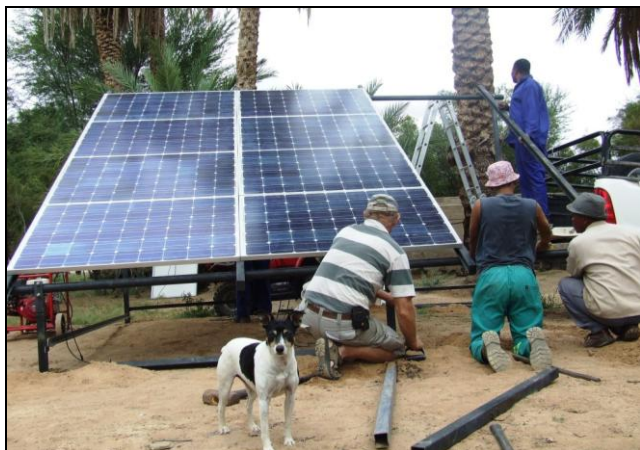
Erecting solar panels at Holoog
